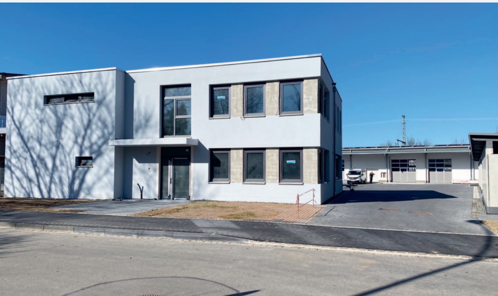
Werkhalle und Ostansicht Verwaltungsgebäude
