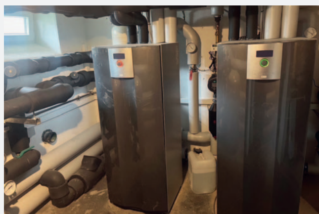
Bild oben: Leitungseinführung über stillgelegte Kamine Bild unten: neue Wärmepumpen im Keller
