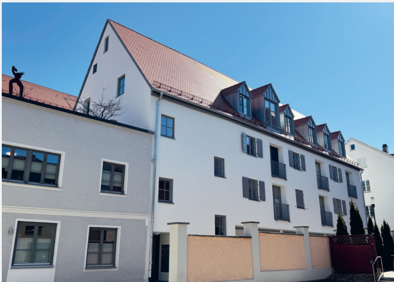
Westfassade und Innenhof
